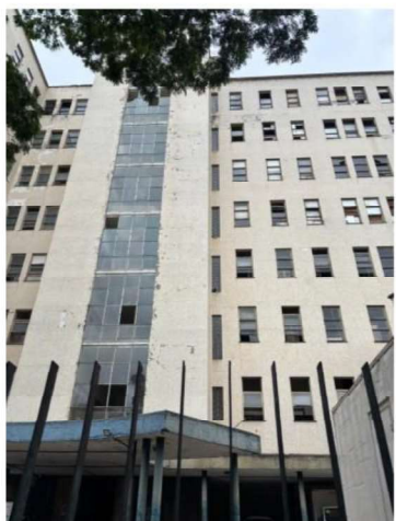
Fachada AG (ausência de pastilhas e parte de esquadrias) - Fonte: Acervo pessoal
