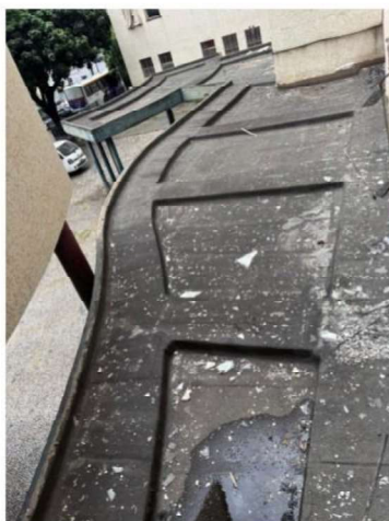
Pastilhas e vidros sobre laje, evidenciando o desprendimento de elementos de fachada
