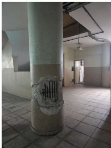
Pilar com armadura exposta Fonte: Acervo pessoal
